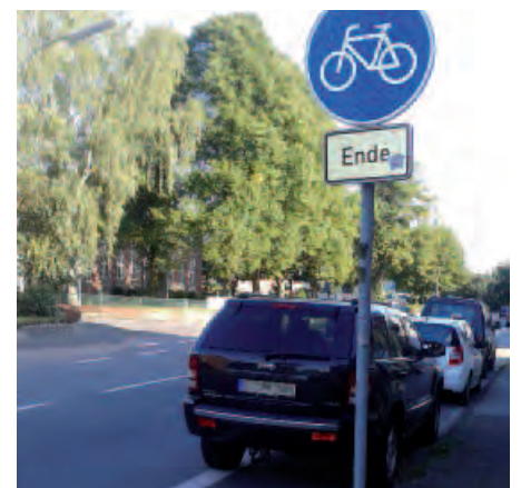
So sieht es häufig für Radfahrer im Rheiner Straßenbild aus: Abrupt endende Radwege, ohne Überleitung in den Straßenverkehr.
